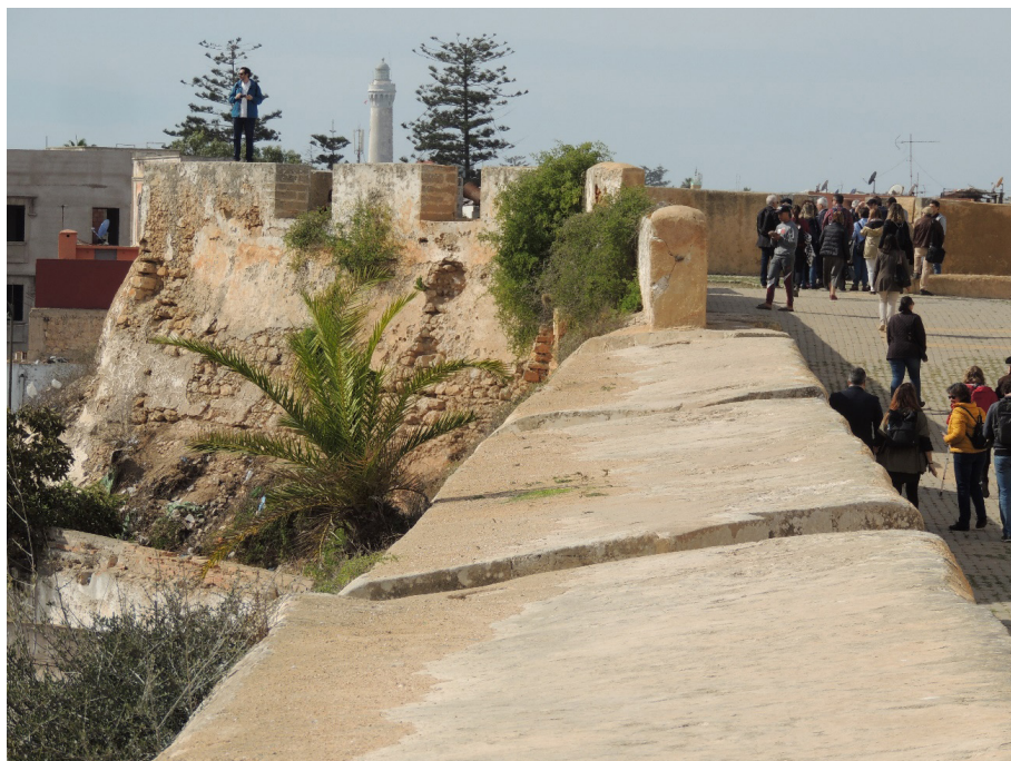
Figura 7: O baluarte do Espírito Santo visto pelo lado do mar, 2019 (foto LCS)
